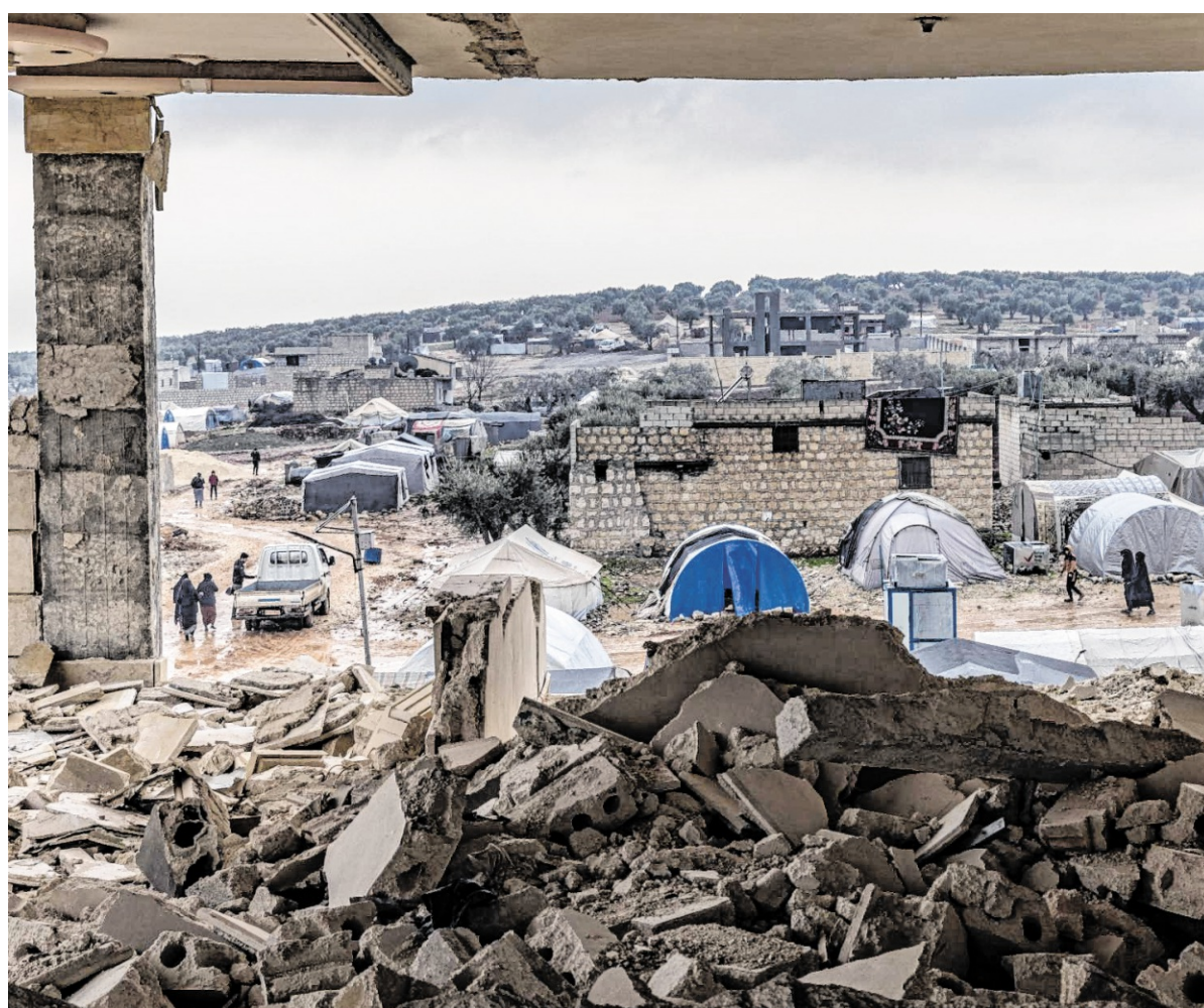
Ein Jahr nach dem verheerenden Erdbeben, das am 6. Februar 2023 die Südtürkei und Nordsyrien erschütterte, ist die Not immer noch groß. Das Bild zeigt ein beschädigtes Gebäude im syrischen Aleppo.
